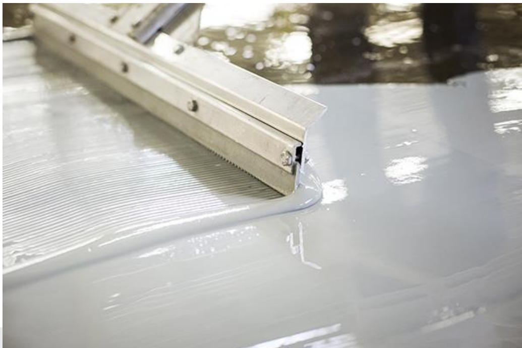
Foto: Aanbrengen vloeistofdicht beschermstelsel.
